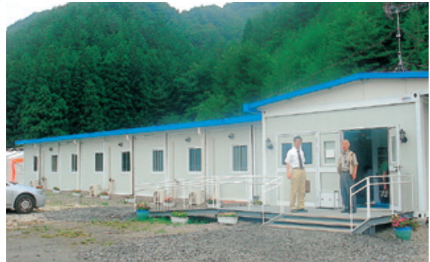
完成した県立大槌病院仮設診療所（7月1日）
