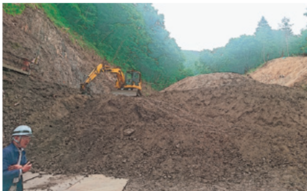
三田貝地区の砂防堰堤工事（5月30日）
