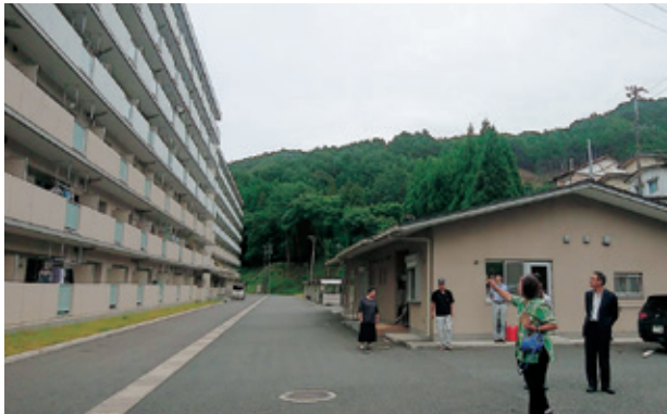
県営では最初に整備された釜石市の平田災害公営住宅（8月10日）
