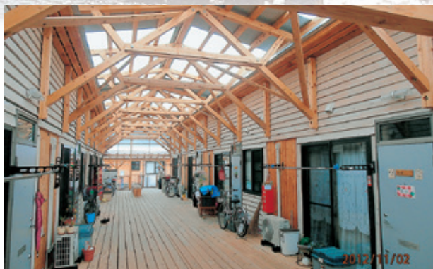
遠野市が東大と連携し建設した木造仮設住宅(11月2日)
