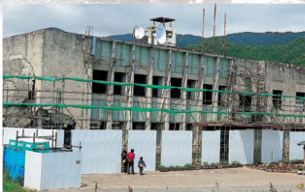
全壊した旧大槌町役場。解体か保存か大きな議論となり、解体へ（6月17日）
