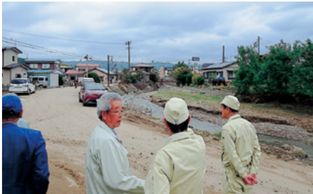
越水した久慈市長内地区の小屋畑川（10月24日）
