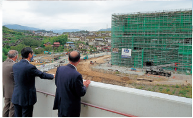
建設中の陸前高田市役所新庁舎を視察（10月1日）
