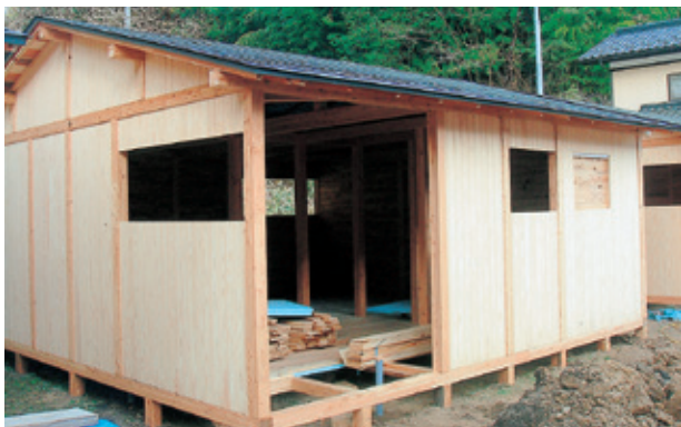
建設中の木造戸建ての住田式仮設住宅 (4月7日)
