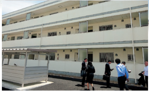
完成した県営南青山災害公営住宅8号棟（RC造3階建24戸）を視察（6月5日）
