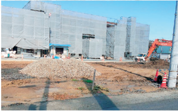
内陸の花巻市に建設中の災害公営住宅（10月30日）
