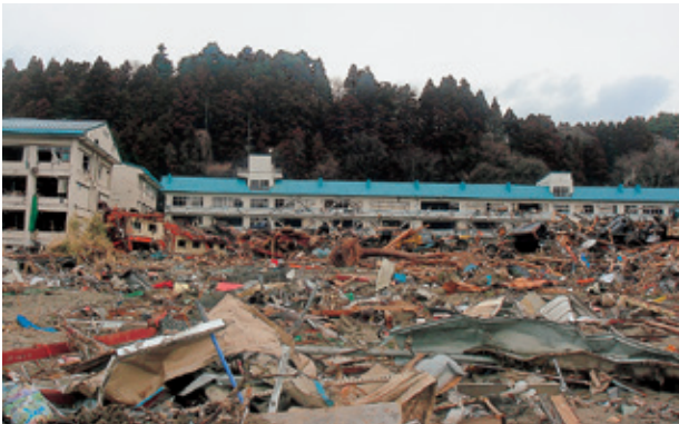
校舎の三階まで津波が押し寄せ全壊した県立高田高校（3月21日）
