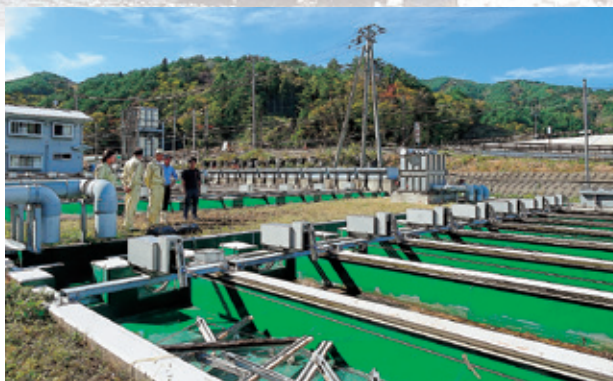
宮古市・重茂漁協の被災したふ化場（10月20日）
