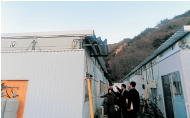
大槌町内の仮設住宅団地を訪問。入居者の方々から物干し竿の雨よけの設置などの要望を受ける（2月20日）
