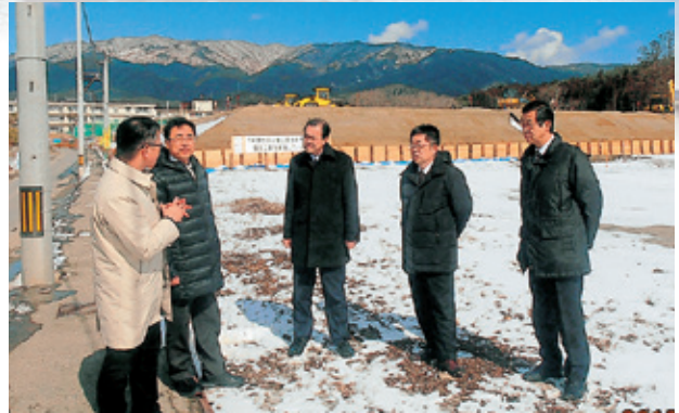
盛土工事が行われている陸前高田市の下和野災害公営住宅の現場を視察（2月25日）
