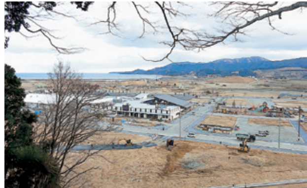
陸前高田市の中心市街地。核となる商業施設がオープン間近（3月25日）
