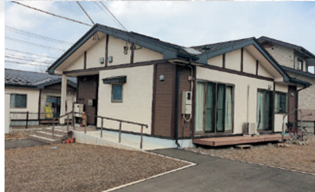
野田村の木造戸建ての災害公営住宅（3月11日）
