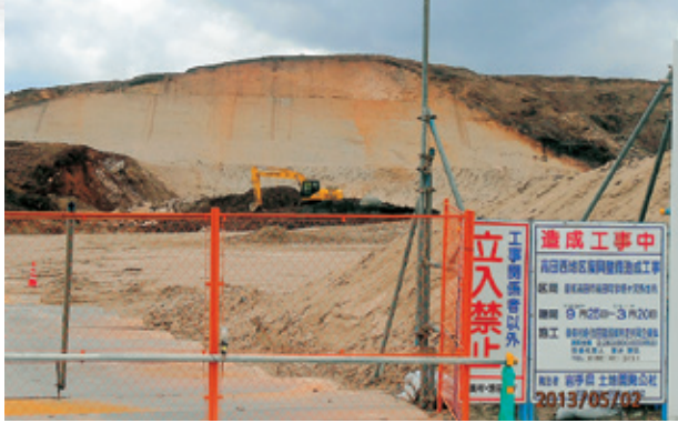
陸前高田市の高田西地区の造成工事が行われている現場（5月2日）
